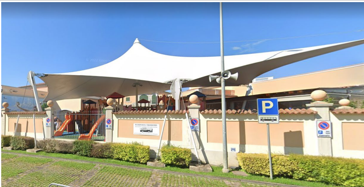
Foto 3: Vista dell'area oggetto di ampliamento lotto A dove è presente attuale playground
