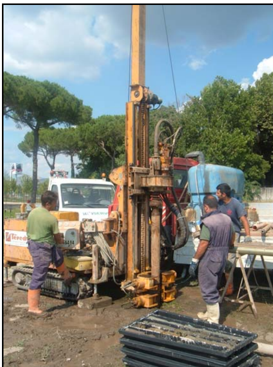
Figura 7 –Sondaggio a carotaggio continuo
